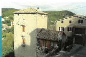
6 Tour de la poterne Elle protégeait l'accès à l'eau pour le château
